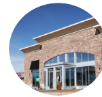
Distribución de baja potencia
